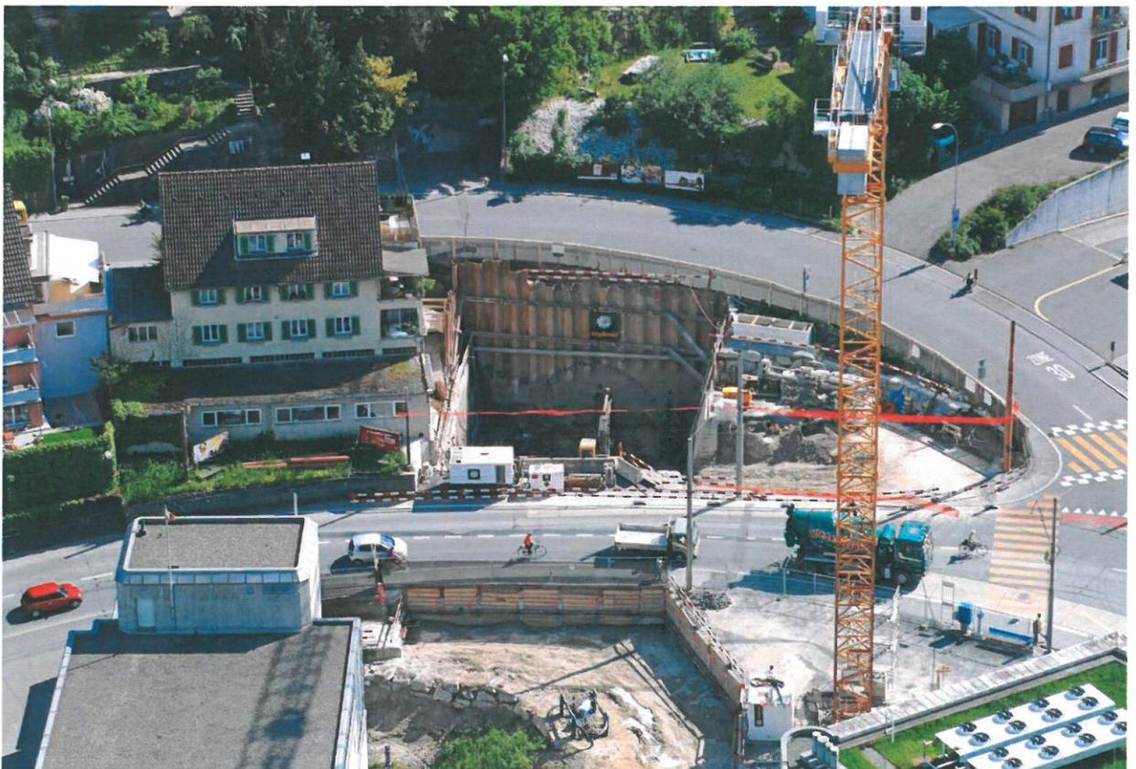
Abb. Flugaufnahme mit den Baugrubensicherungsmaßnahmen
