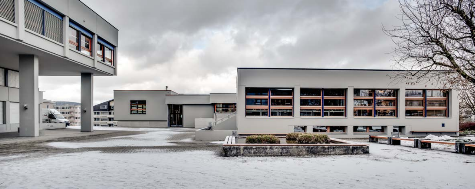
Aussenansicht Trakt A, B und C
