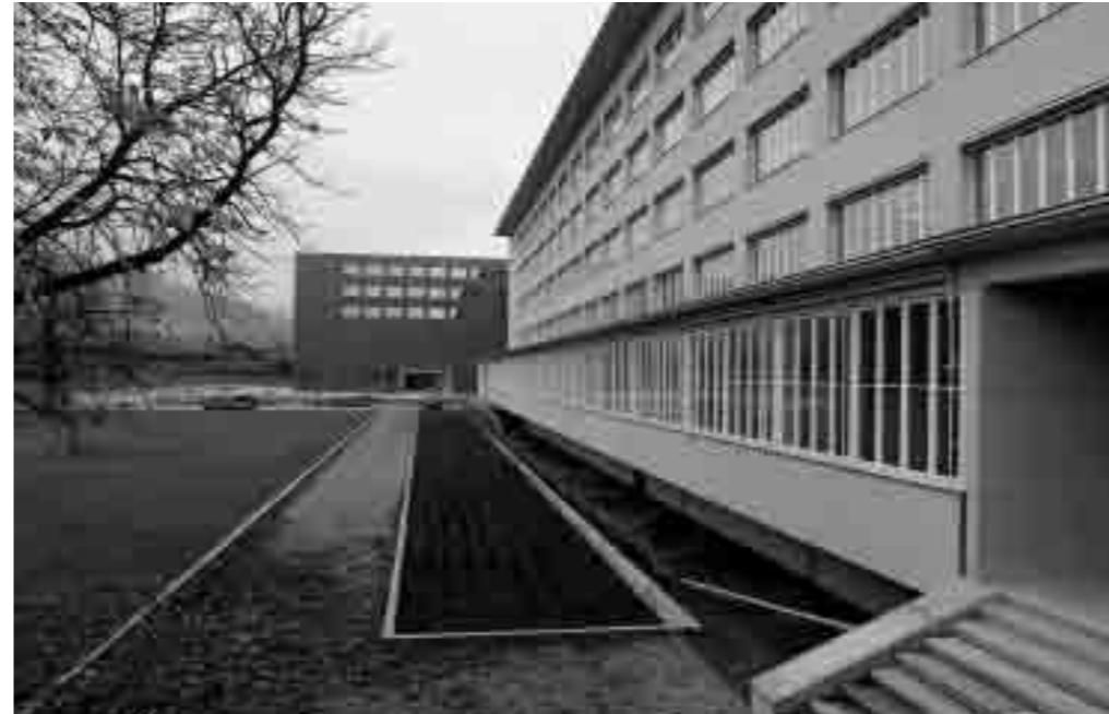
Der «Meiligraben» längs der Südfassade
