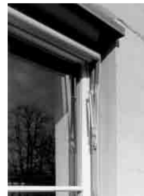
Detail Fenstersturz- bzw. -leibung während und nach der Sanierungsarbeiten
