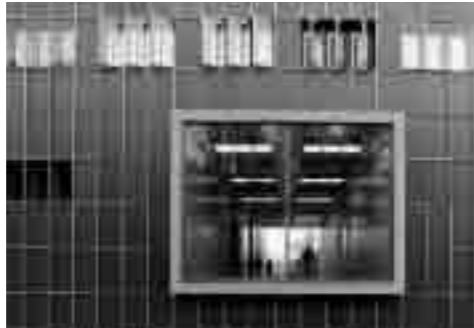
Neubau mit Nordfassade und Panoramafenster
