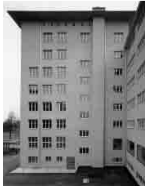
Westfassade vor und nach der Fassadensanierung
