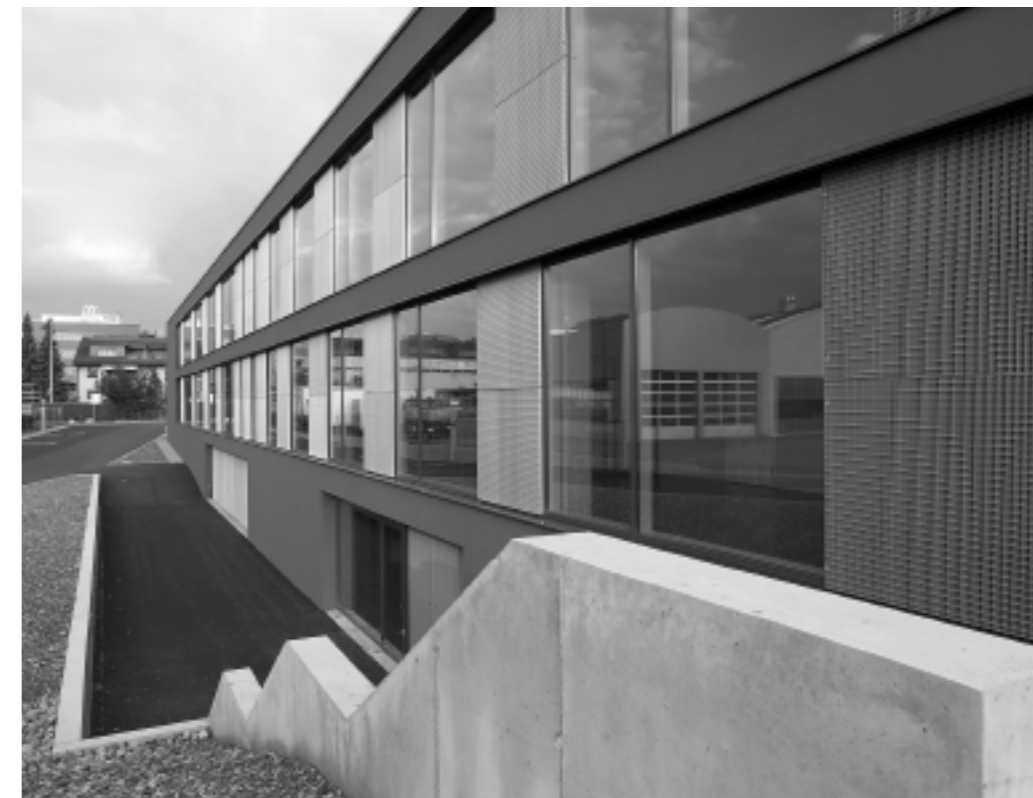
Nordfassade mit Zugang Untergeschoss
