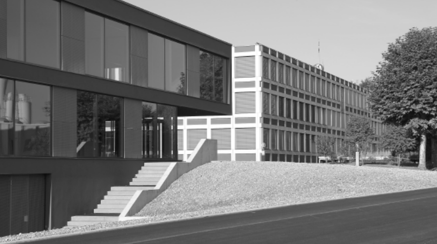
Ausschnitt Nordfassade mit bestehendem Gebäude im Hintergrund
