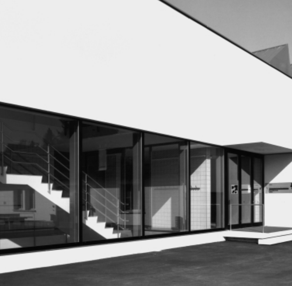
Fensterfassade von Süd-Ost mit Eingang
